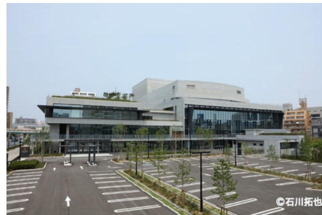
フェニーチェ堺外観
