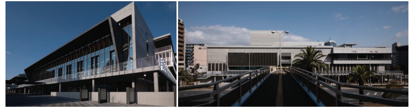
建物周囲を巡る空中歩廊は、観劇のアフターシアターの場となる
