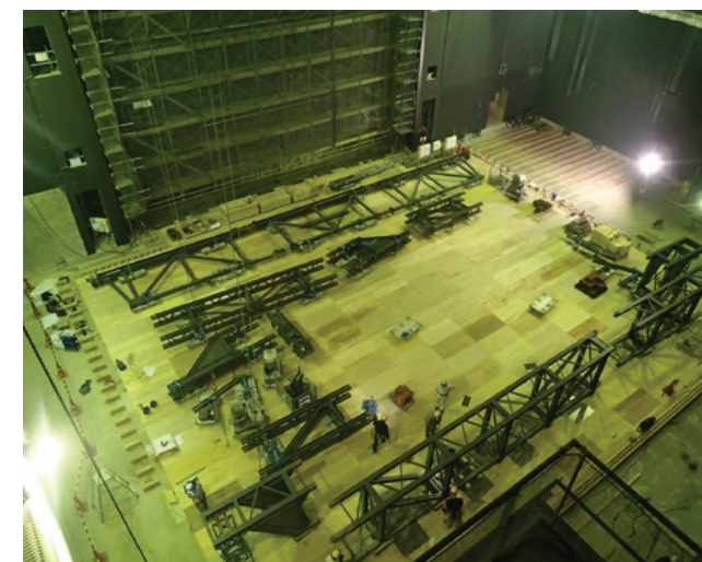
大ホール 舞台面 反射板組立状況
