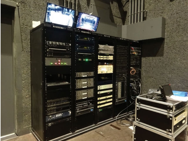
舞台下手袖パッチ架・舞台連絡設備架・映像モニタ架
