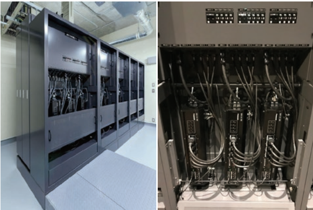
移動調光器収納盤 調光／直回路を自由に供給できます
