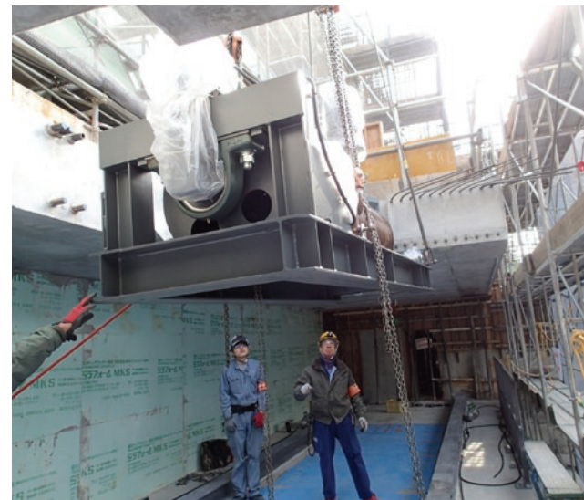
大ホール 第3マシンギャラリー 反射板マシン搬入状況
