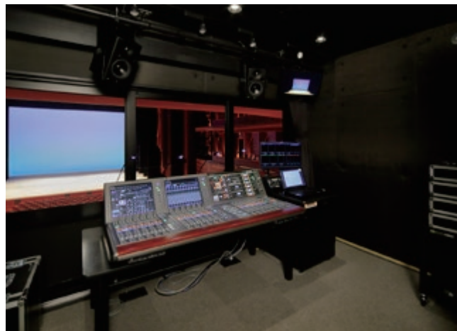
ザ・グランドホール 音響調整室
