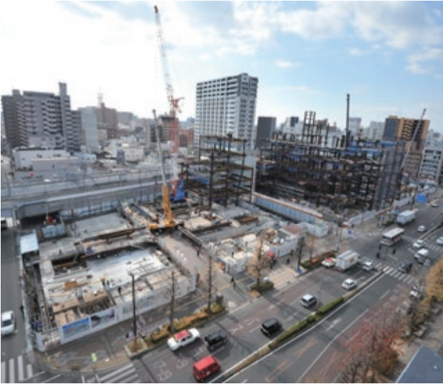
工事中の様子
