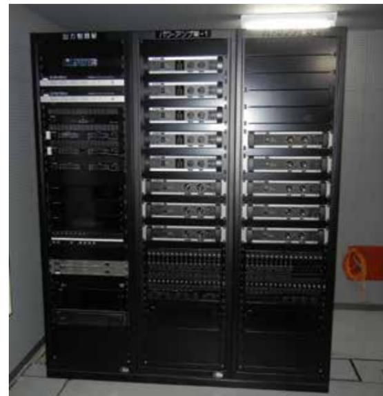
写真-3 大ホール 放送室 (出力制御架/パワーアンプ架)
