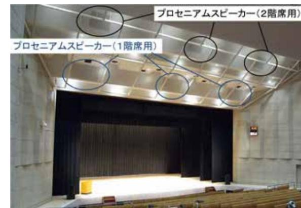
写真-4 大ホール プロセニアムスピーカー配置
