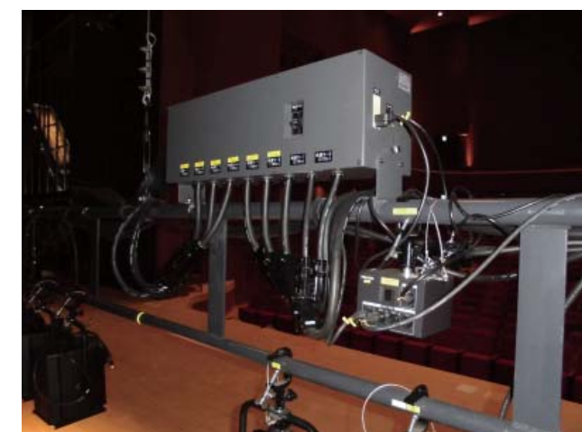
サスペンションポット電源ボックス・DMXノード
