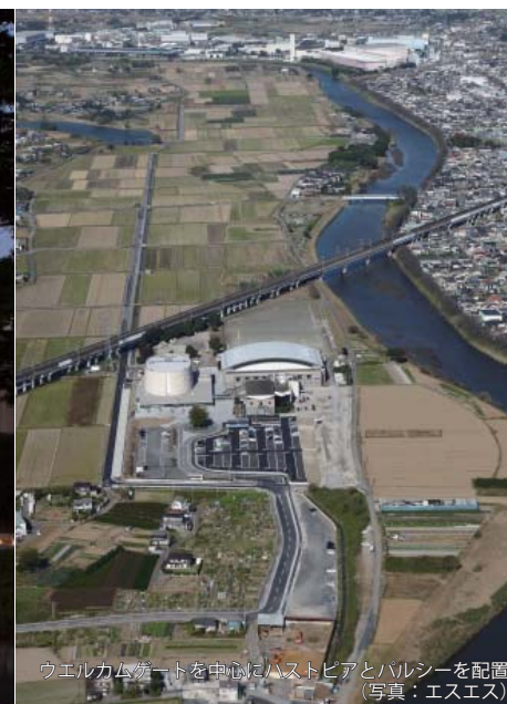
外観夕景 / 開放的な低層部とシンプルな楕円形のホールは、敷地の近くを走る東北新幹線の車窓からも蓮田市の新しいシンボルとして印象づけられている (写真：エスエス)
