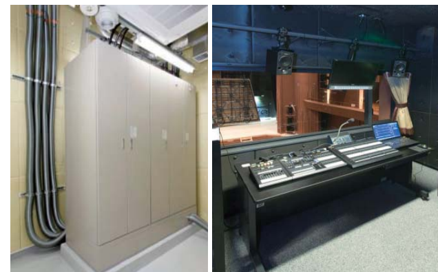
(左より) 主幹盤・分岐盤
