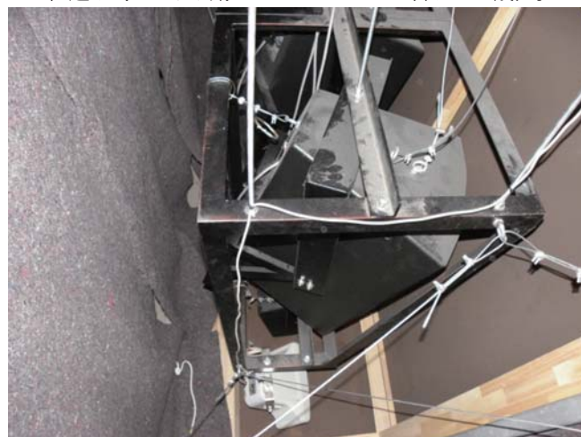
【プロセニアムスピーカー】 MK5366i(2台)+MK2396i(1台)
