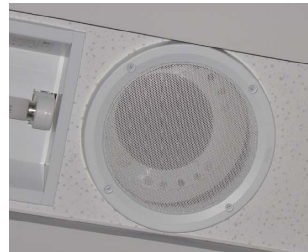
【天井埋込型スピーカー設置の様子】
