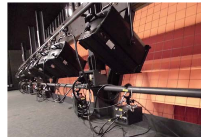
シーリングスポット電源ボックス・DMXノード
