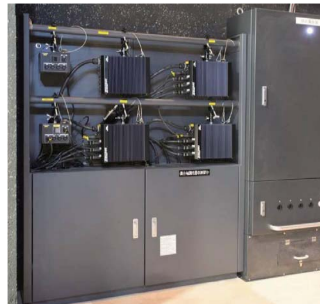
(舞台下手側) 移動型調光器収納架・持込機器用電源盤
