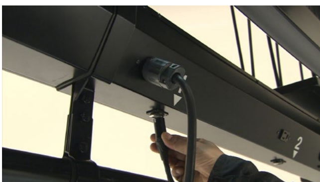
照明バトンの電源と信号コンセント
