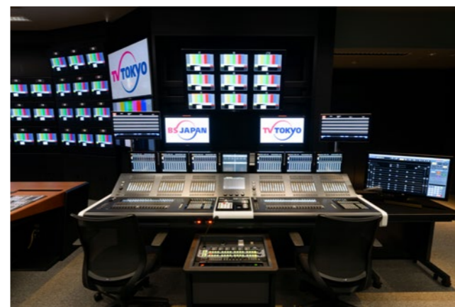
第1スタジオ照明操作卓
