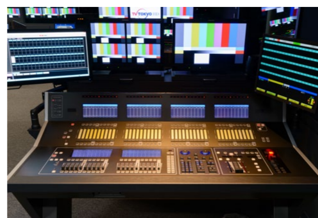
第3スタジオ照明操作卓
