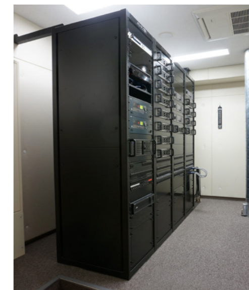
【大ホールアンプ室】
