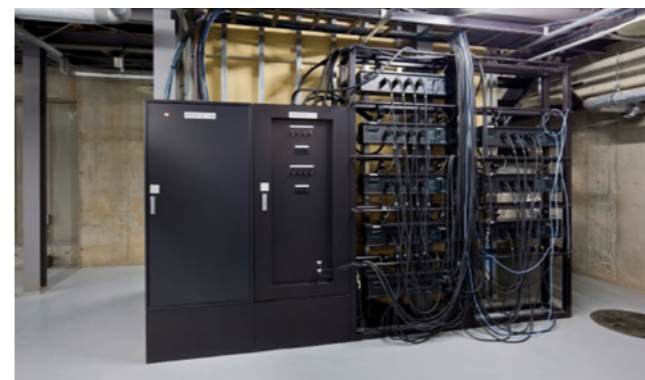
フロア周り調光電源供給用の移動型調光器用分電盤
