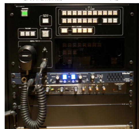
【ホール舞台袖 ローカル操作部】
