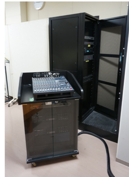
【音声ワゴン・パワーアンプ架（倉庫にて）】
