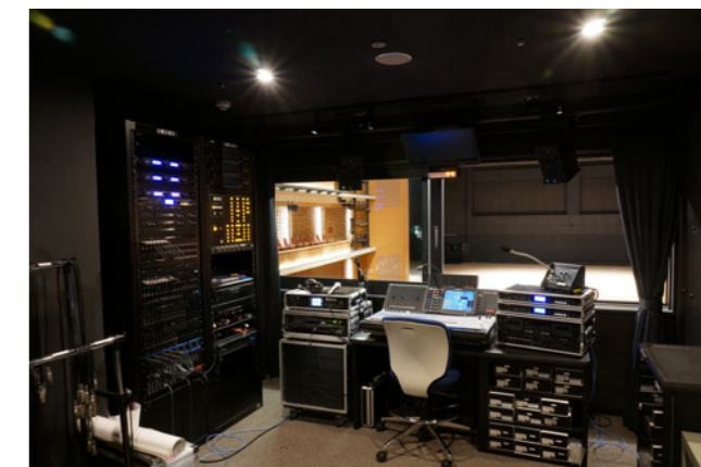
【大ホール音響調整室】
