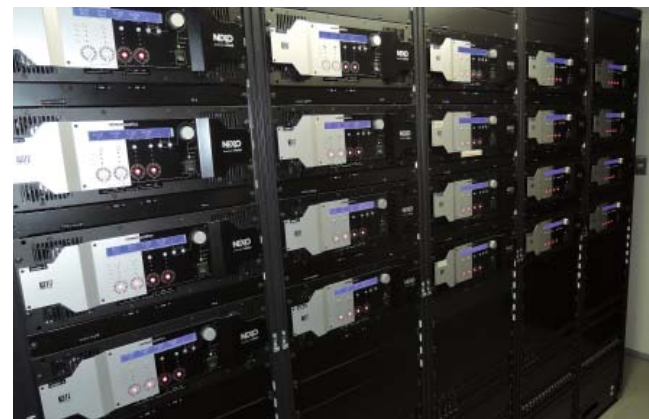
写真2. NEXO社NXAMPが組み込まれたパワーアンプ架
