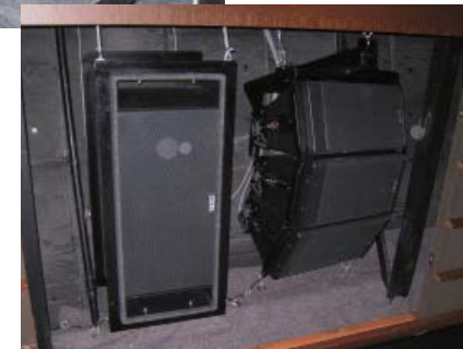
写真4. スピーカー設置状況 (左上:サイドスピーカー、右下:プロセニアムスピーカー)
