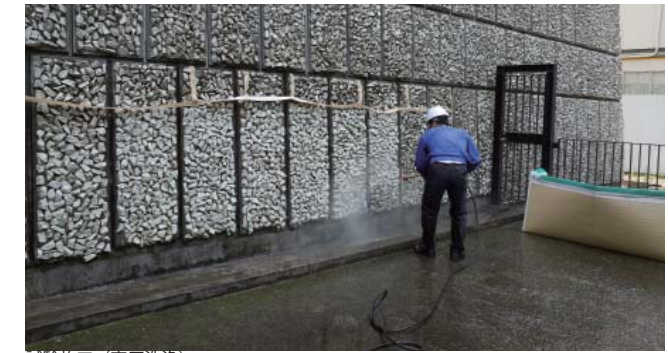
試験施工 (高圧洗浄)
