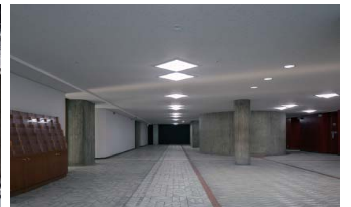
既存照明のLED化 (1F 楽屋ロビー)
