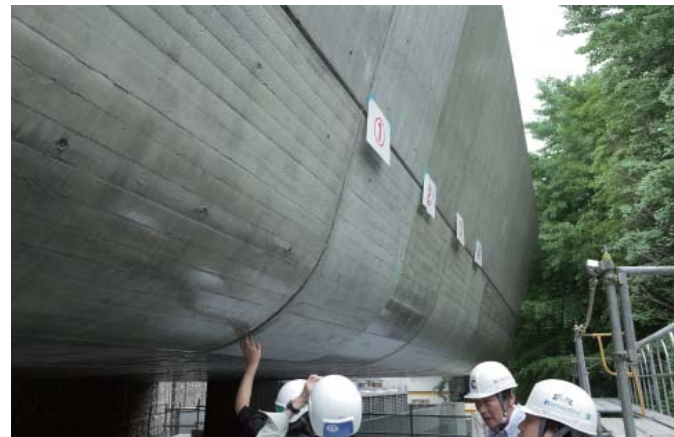
外壁西側での試験施工
