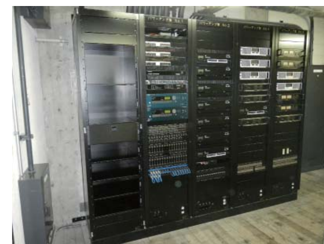
写真8. パワーアンプ架
