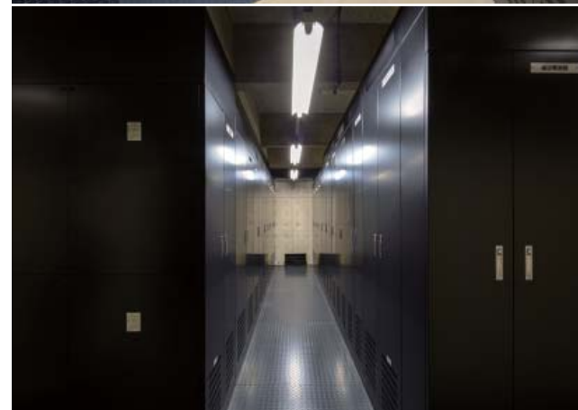
大ホール 調光器盤 (上：1階調光ユニットA室/下：地下2階調光ユニットB室)
