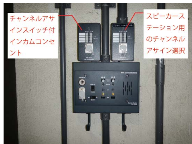
写真9.チャンネルアサインスイッチ付きプレート
