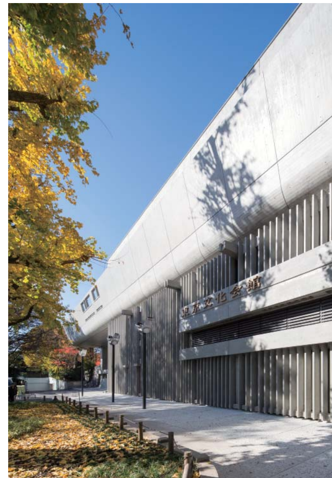
竣工 (東側外壁)
