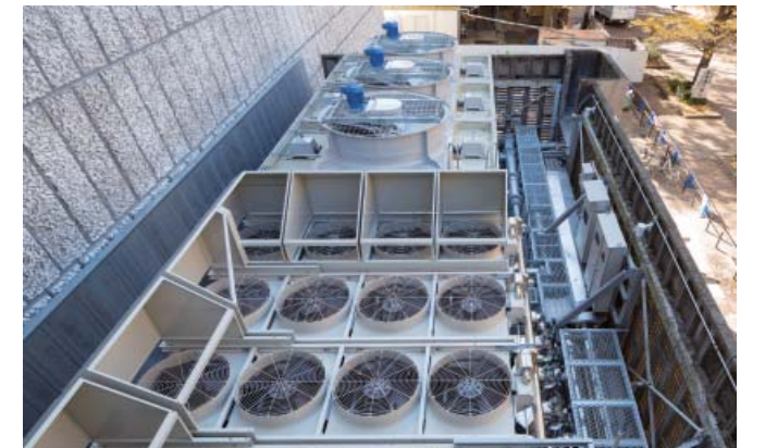
冷却塔・ヒートポンプチラー
