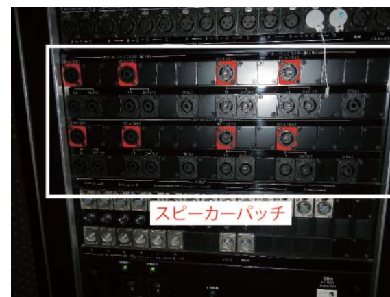
写真13.スピーカーパッチパネル(旧音響調整室)
