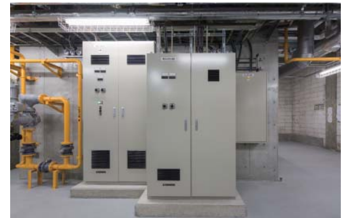
震災対応変圧器盤・震災対応分電盤
