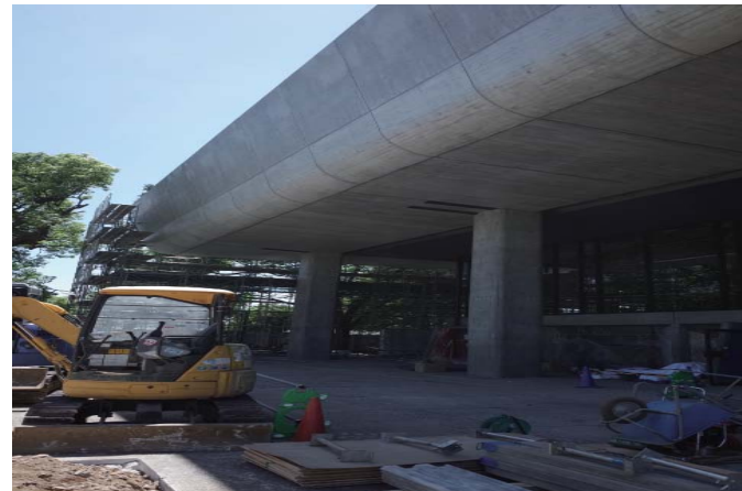
足場解体状況
