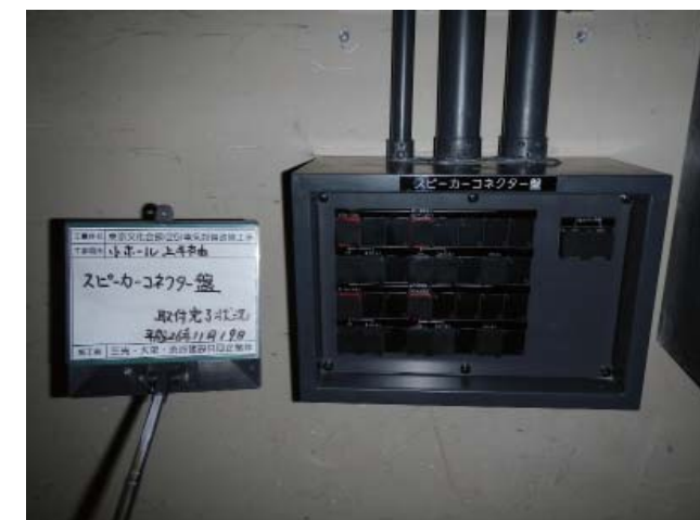
写真14.舞台上手袖のスピーカーコネクタ盤
