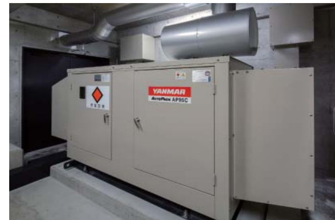
震災対応発電機
