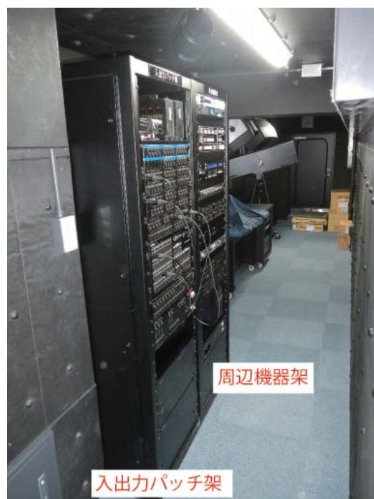
写真11.入出力パッチ架と周辺機器架 (新音響調整室)
