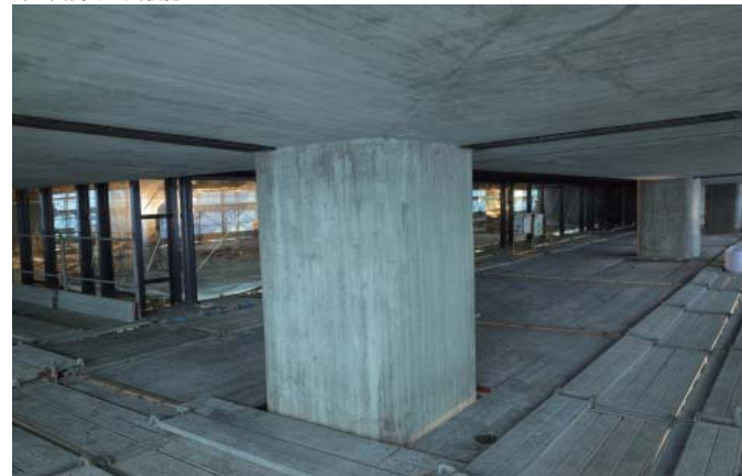
既存塗膜除去施工状況
