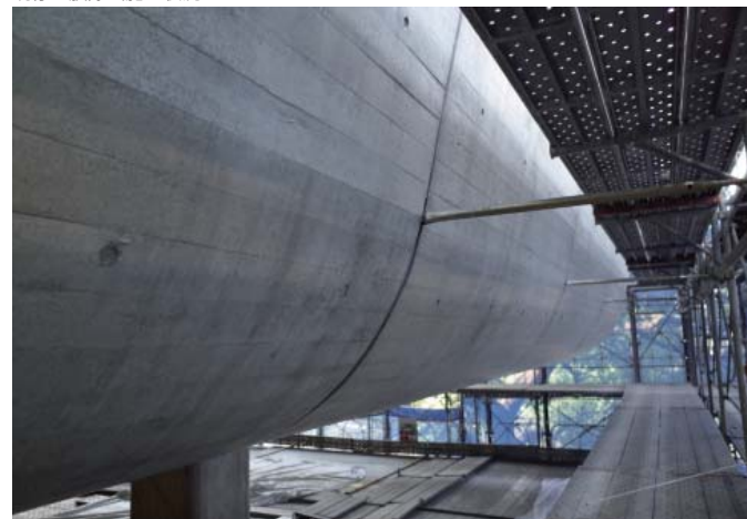
色合わせ施工状況
