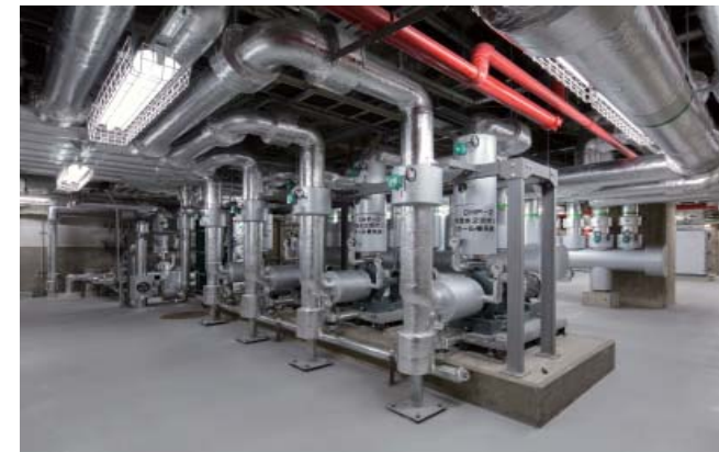
冷水二次ポンプ
