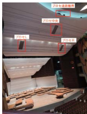
写真1. プロセニアムスピーカー群
