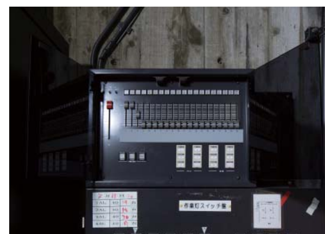
大ホール 舞台袖操作盤
