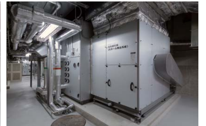
空調機 (大ホール舞台系統)
