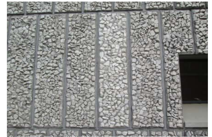
試験施工 (透明の被覆型落下防止コート)
