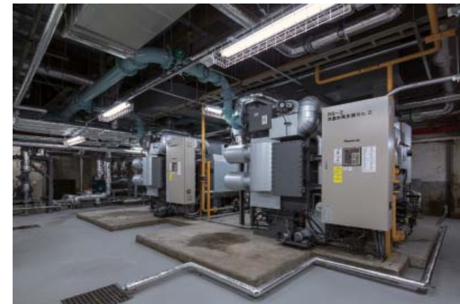
冷温水発生器
