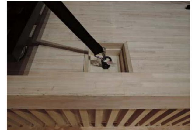
写真4. 舞台床スピーカー転倒防止用フック
