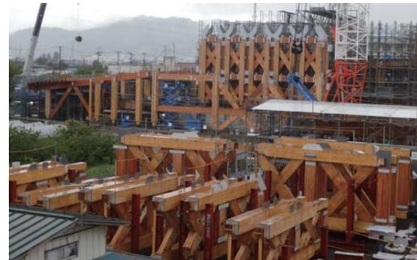
大ホール トラス梁の地組み 写真提供：戸田建設
