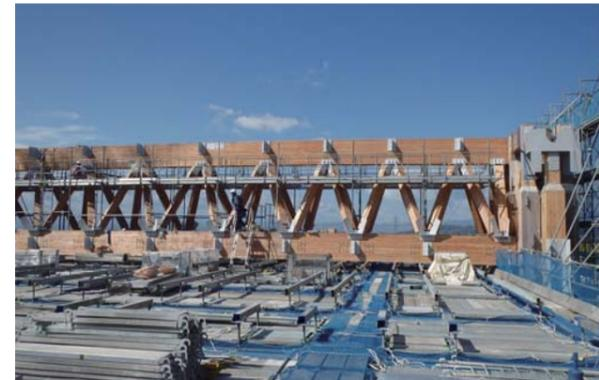
大ホール トラス梁の設置 写真提供：戸田建設
