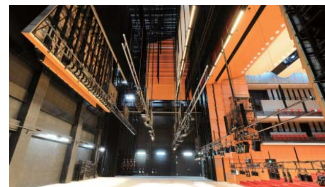
写真-3 吊物機構 (下手袖より)
