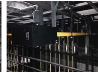
写真-8 下手袖綱元上部位置検出器 (下手舞台奥より)
