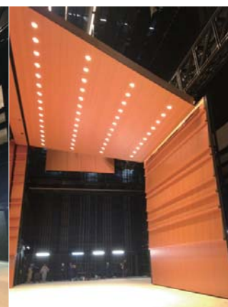
写真-10 天井・正面反射板 セット完了 (上手袖より)
