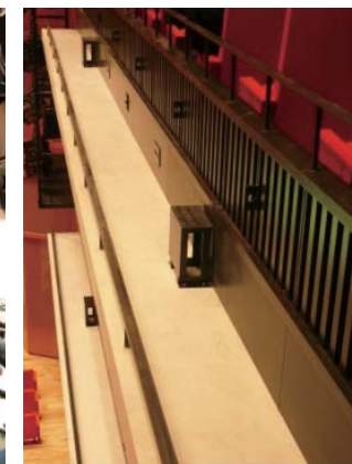
バルコニー部乗込みステップ及び安全帯用フックの設置
