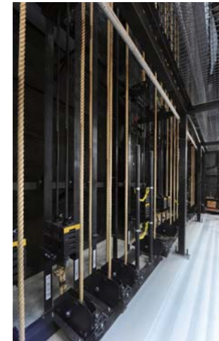
写真-7 下手袖綱元カウンタウェート (下手舞台前より)
