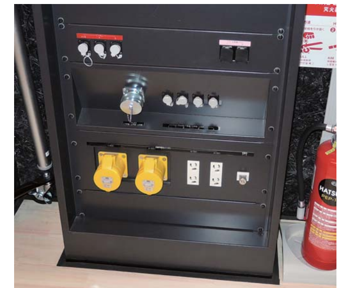
写真4. 舞台内のコネクター盤の電源コネクター
