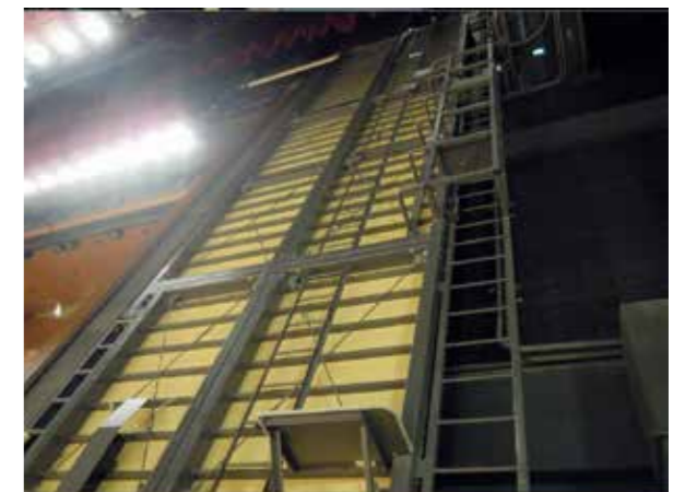
■ 7 ウィンゲータ型トーメンタルタワー
