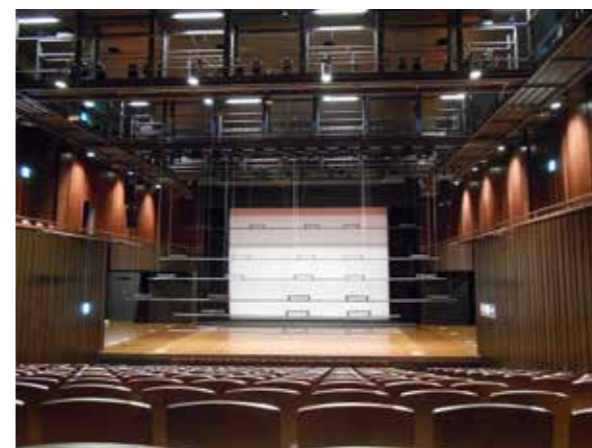
写真-1 小ホール吊物
