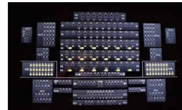
写真6 大ホール 負荷モニター画面
