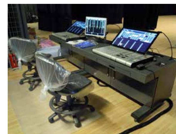
写真-3 大ホール操作卓一式
