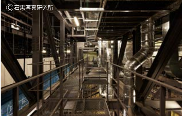
写真9: 大ホール天井裏キャットウォーク
