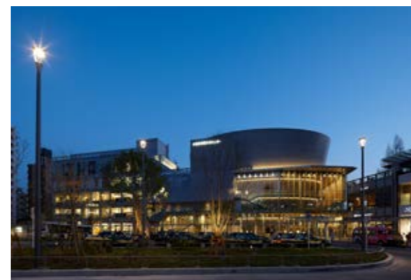
写真3 駅側よりの施設全景
