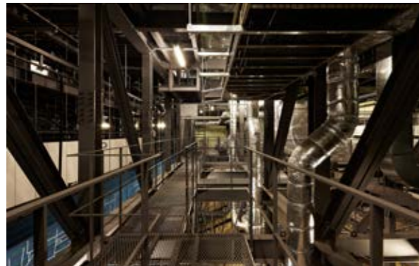
写真-8 大ホール天井内キャットウォーク
