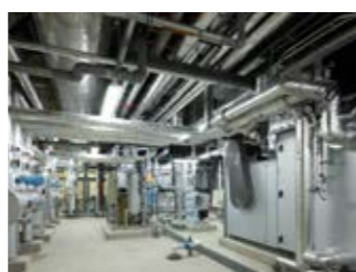
写真11 地下1階熱源機械室
