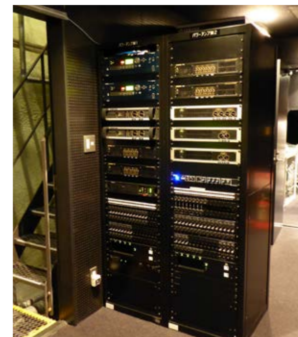
写真-6 音響調整室のパワーアンプ架
