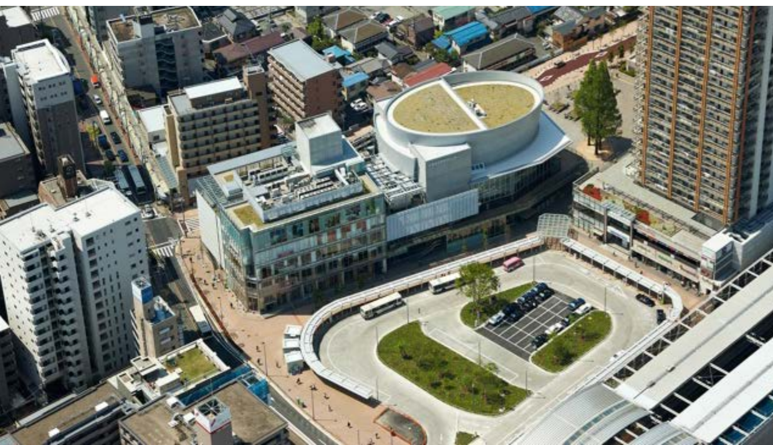
▼駅前広場とフェスティバルコートに面した市民交流センター※
