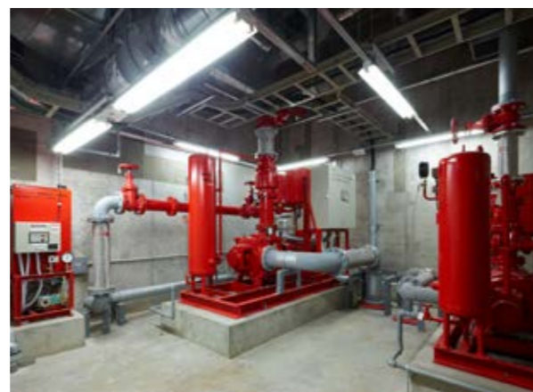
写真13 地下1階消火機械室
