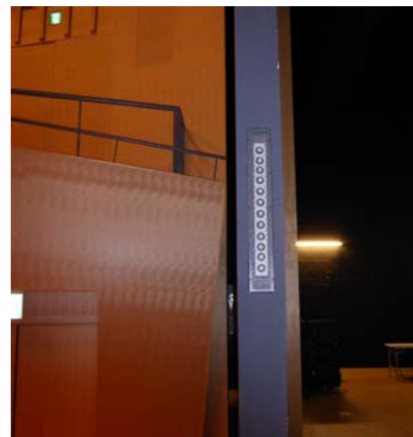
写真-4 固定はね返しスピーカー (サイドパネルに組込)
