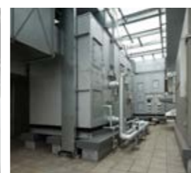
写真12 2階屋上空調機置場
