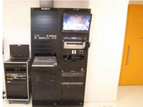
写真-5 主ホール 舞台監督卓と舞台下手音響機器
